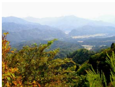
林道から内の倉ダムを望む
